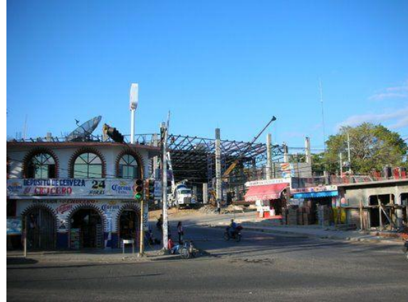
Construcción de Chedraui Puerto Escondido, 2008
